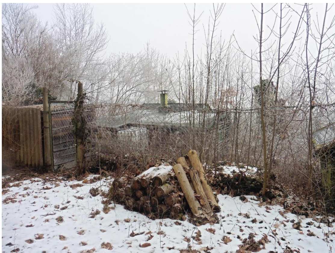
Nordansicht der bestehenden Forsthütte
