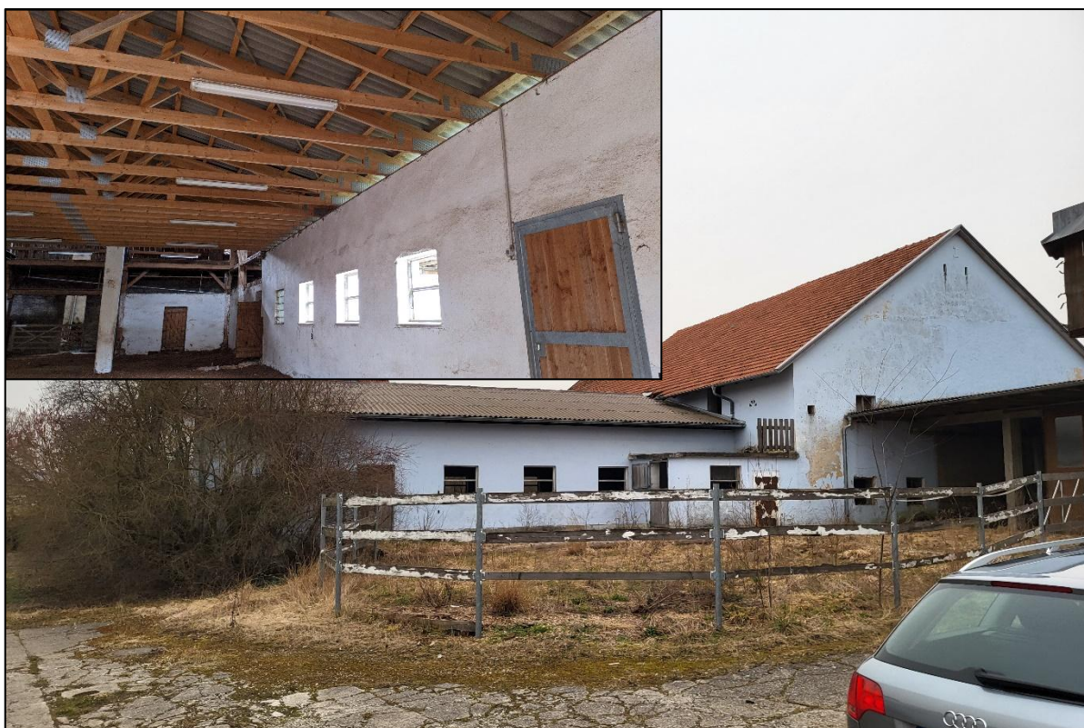
Abbildung 8: Größere Pferdescheune im Süden, entlang der Zufahrt
