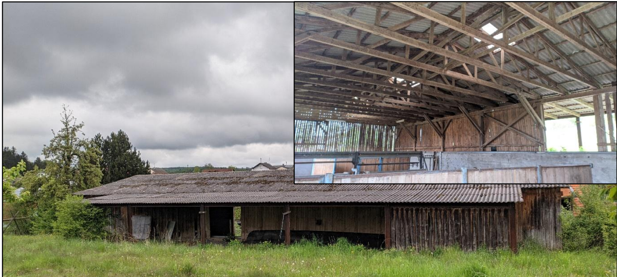
Abbildung 7: Kleine leerstehende Scheune im Norden
